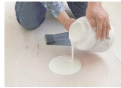
※ビールアップ工法
